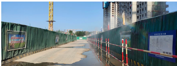
现场围挡设置喷淋除尘
