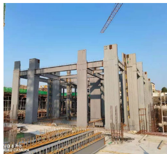
地块项目钢结构住宅首层施工
