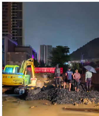
利用挖掘机疏通河道
