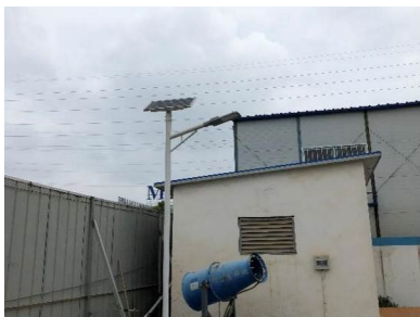
施工现场设置太阳能路灯进行照明
