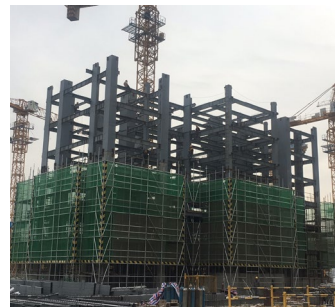
地块项目钢结构住宅标准层施工
