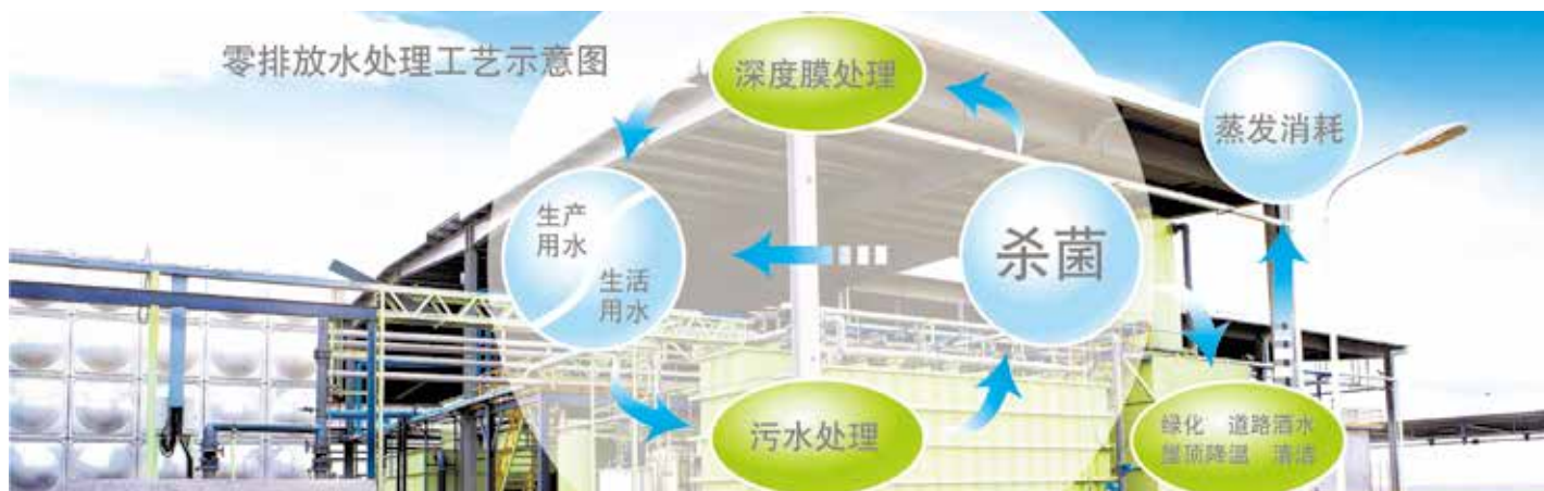
广汽本田增城工厂污水处理站
