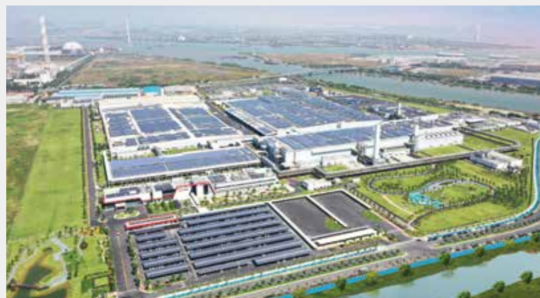
广汽丰田新能源汽车产能扩建项目二期俯瞰图
