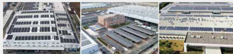
广汽部件园区光伏项目建设
