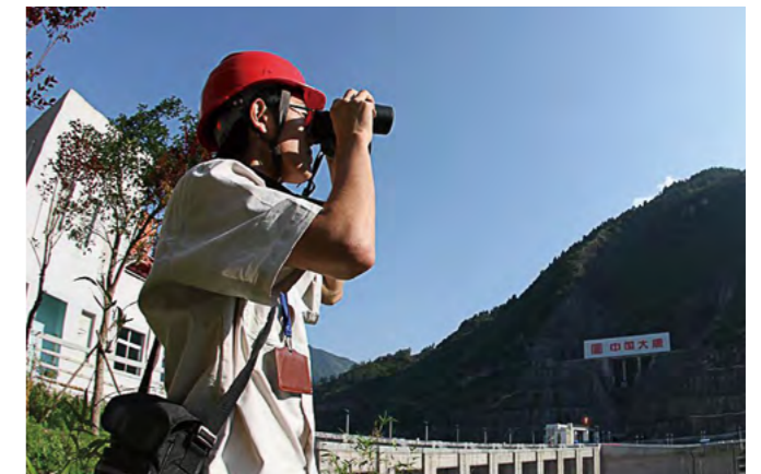
彭水水电公司严格做好大坝安全监测,守卫大坝安全
