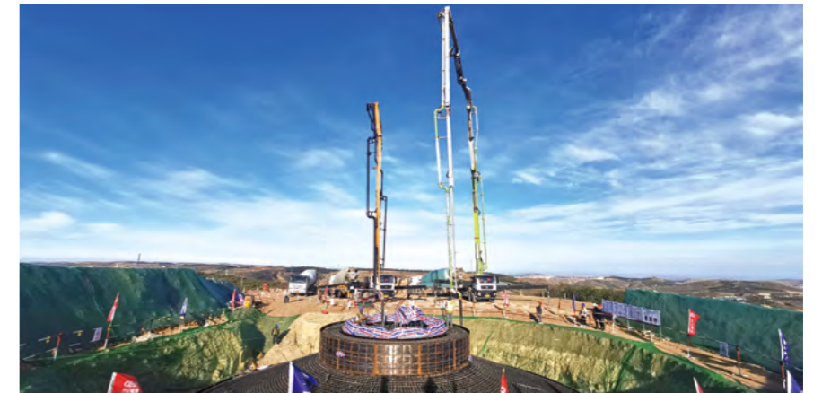
清水河新能源项目建设现场
