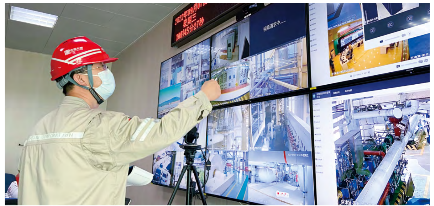
高井热电公司升级改造视频监控系统
