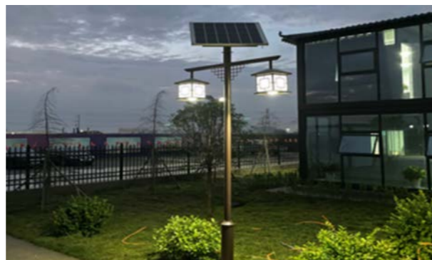
◎ 六化建项目现场生活区使用太阳能路灯
