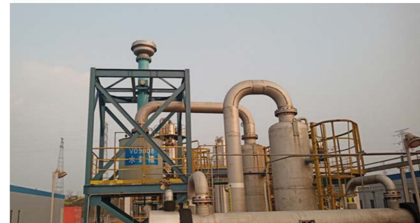
© 华陆新材生产尾气吸收处理装置放空筒和污水处理站尾气处理装置放空筒
