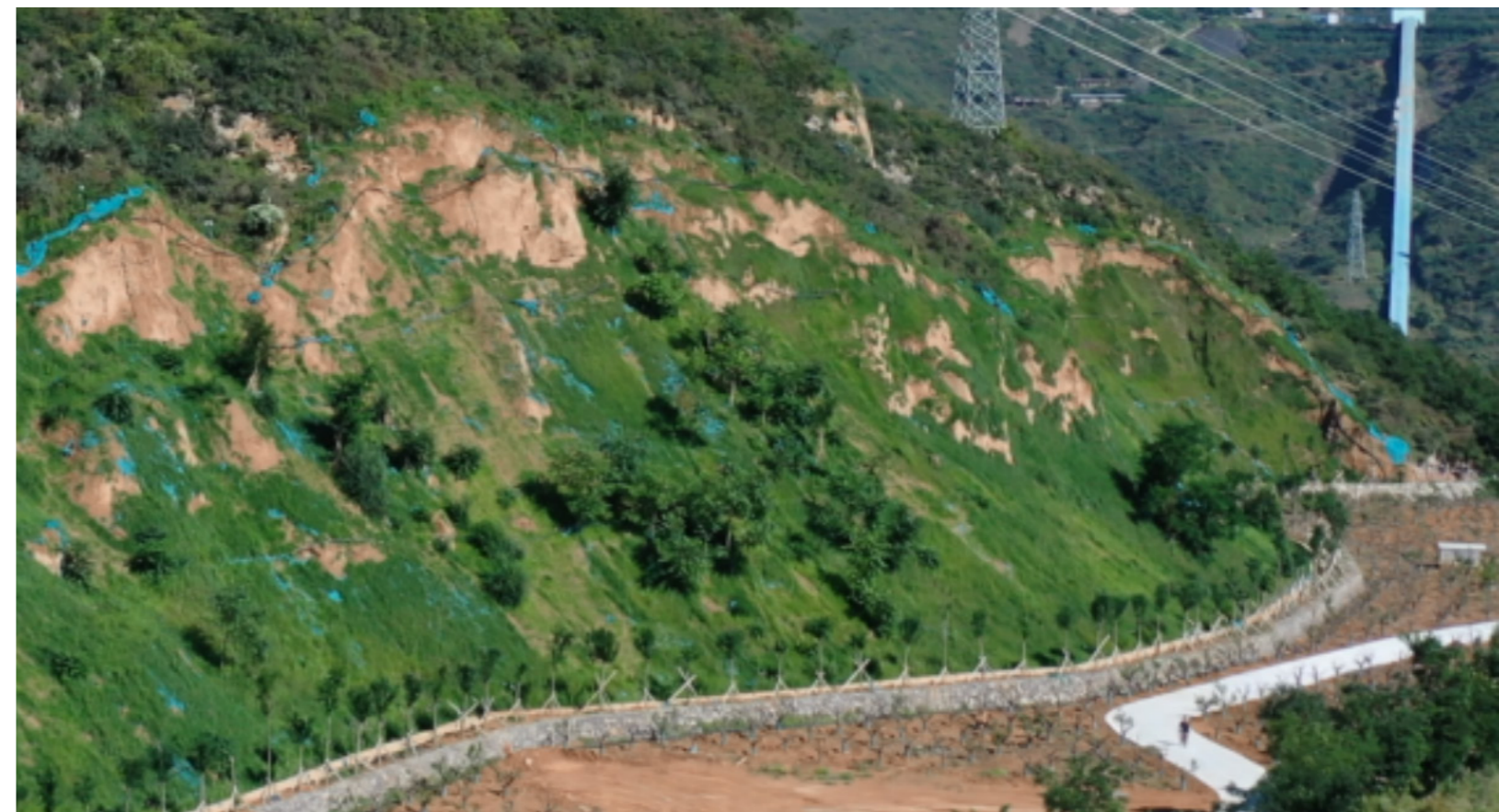
◎二公司生态修复项目坡面挂网客土喷播
