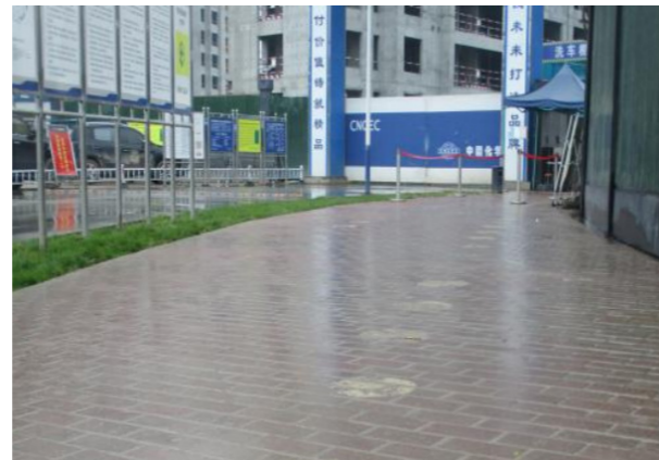
◎四公司西咸新区项目人行道铺设透水砖吸音降噪
