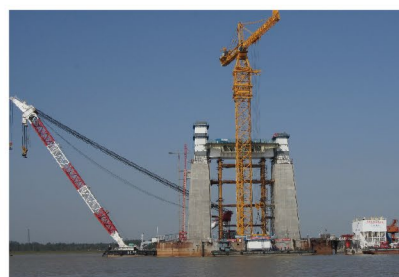
首创悬索桥钢-混凝土叠合主塔
