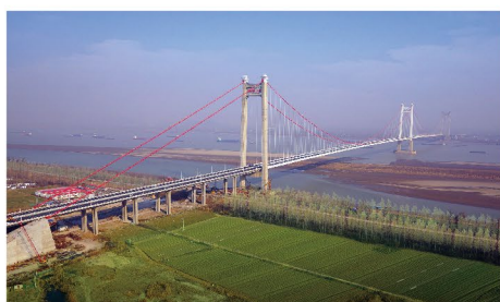
首创了适应河势的三塔连跨悬索桥桥式
