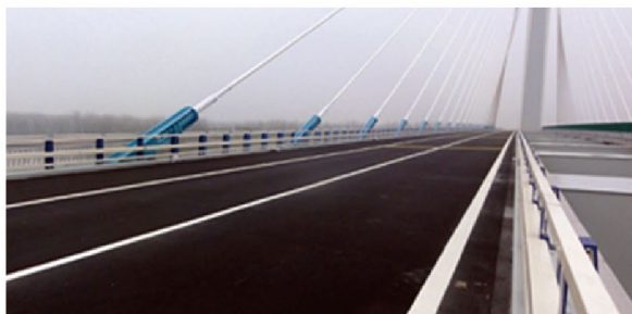
桥面及高分子聚合物超薄铺装技术的研发
