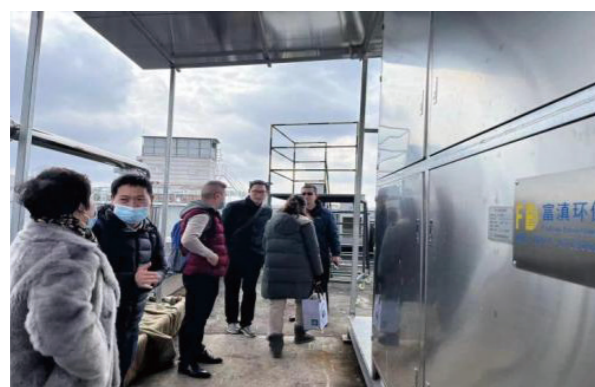
提取一车间 VOCs 治理工程环保验收
