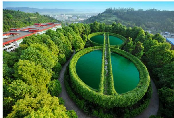
“万吨高位水池”由绿荫覆盖的环形建筑万吨高位水池组成，包括进水池和出水池，主要功能是调度生产和生活用水。两池连通，每个水池可储水5,000吨。
