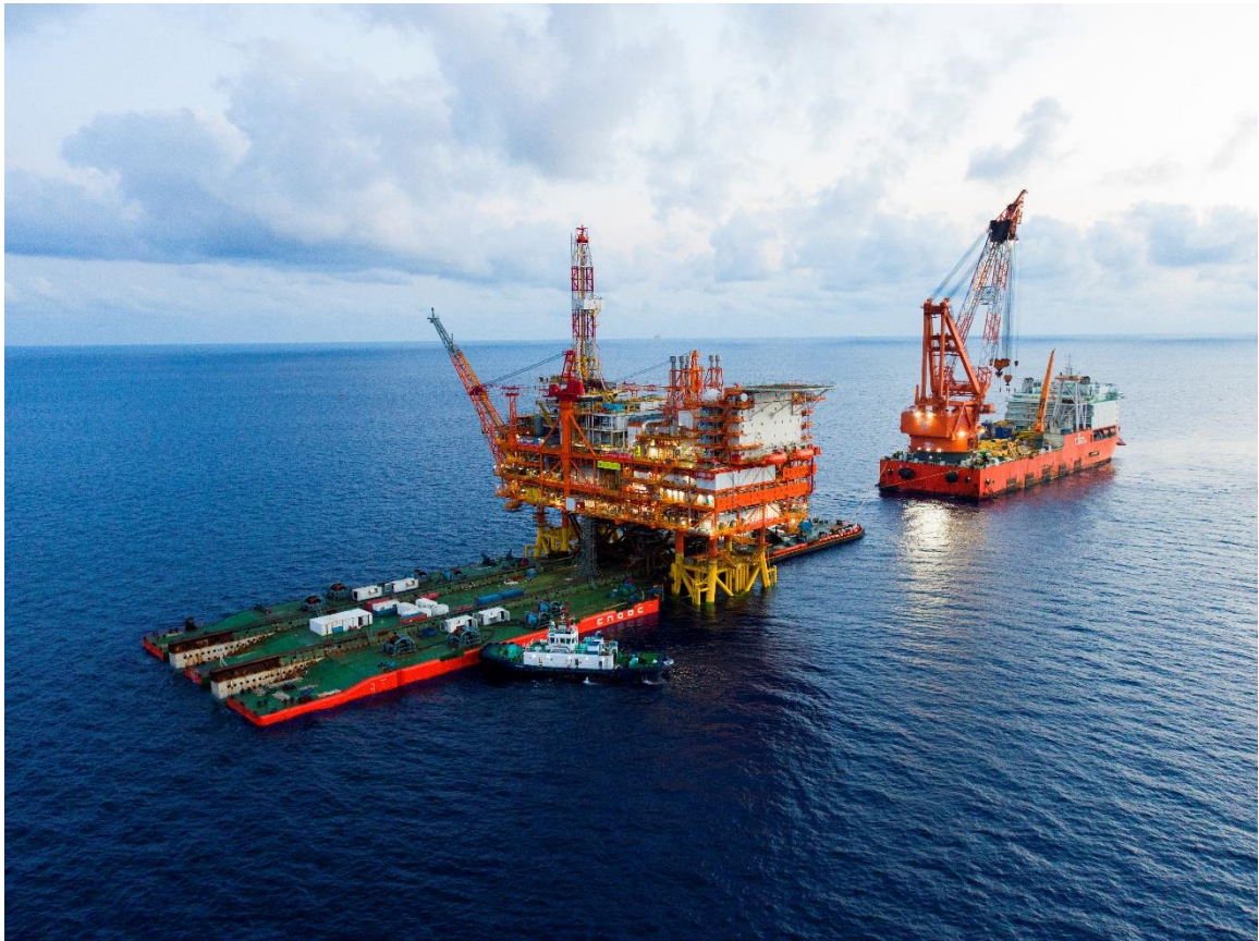
恩平浮托现场
