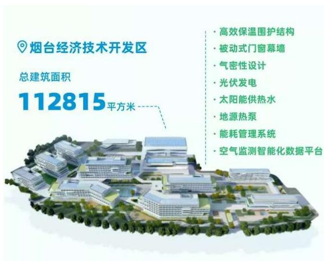
该示范项目按照国家近零能耗建筑设计建造，建筑本体节能率达到 90%以上，不仅采用了聚氨酯保温围护结构，还采用了最新型保温性好、具有耐火功能、低碳节能的复合材料节能窗，充分利用多种可再生能源，将光伏发电、地源热泵和发电玻璃、太阳能热水相结合，可满足整个社区 30%能源消耗。
