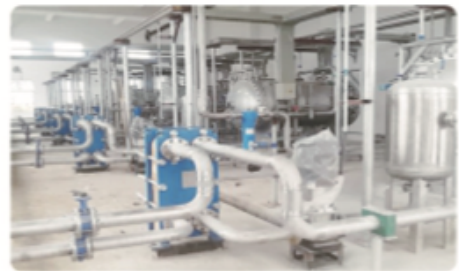
吉林石化污水厂深度处理工程
