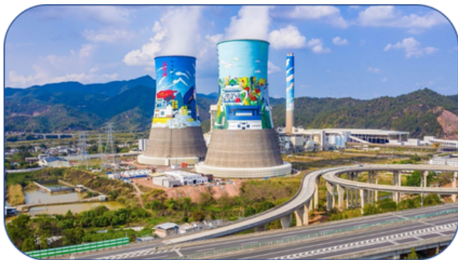
广东粤电大埔电厂二期电除尘+MGGH
