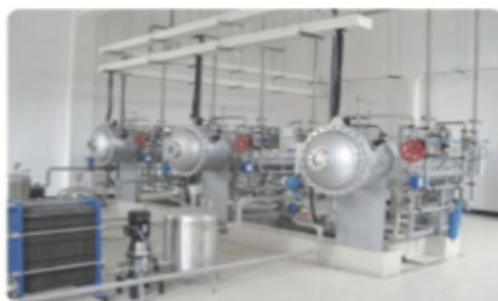
福州东南水厂自来水深度处理工程
