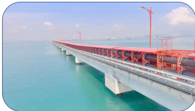
印尼爪哇工程圆管带式输送系统
