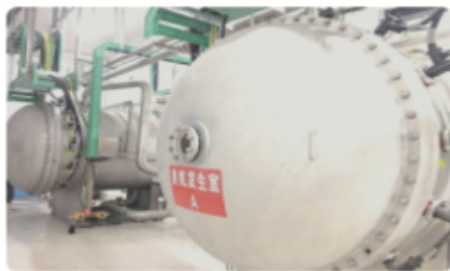
济南金鸡岭热电厂热水锅炉 烟气脱硝改造工程
