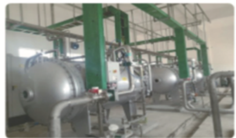
福清融元污水厂污水处理工程
