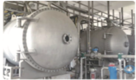
嘉兴市联合污水处理厂提标改造工程
