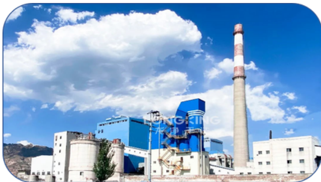
内蒙山晟能源1# CFB炉超低排放装置
