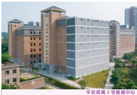
平安观澜3号数据中心
