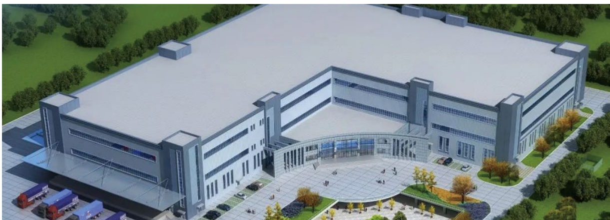
九冶承建的新疆维吾尔自治区新华书店物流基地项目荣获第十五届“中国钢结构金奖”
