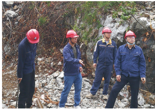
长勘院检查组现场指导工作
