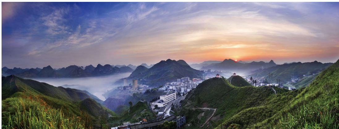
广西华锡集团有限公司铜坑锌多金属矿
