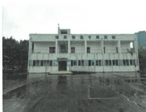
未经登记建筑-CFS 办公楼
