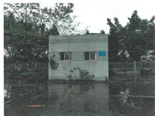
未经登记建筑-CFS 办公楼旁公厕
