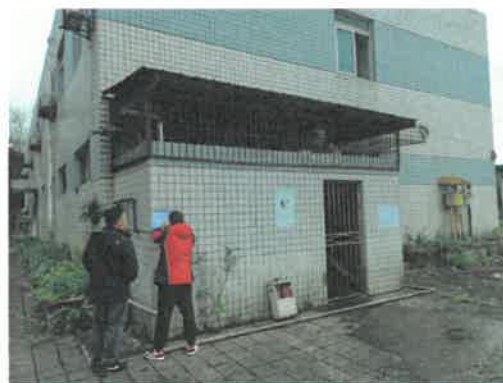
未经登记建筑-侯工楼库房
