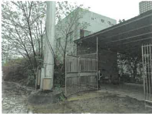
未经登记建筑(经认定为有证房屋) - 规划前方调度楼
