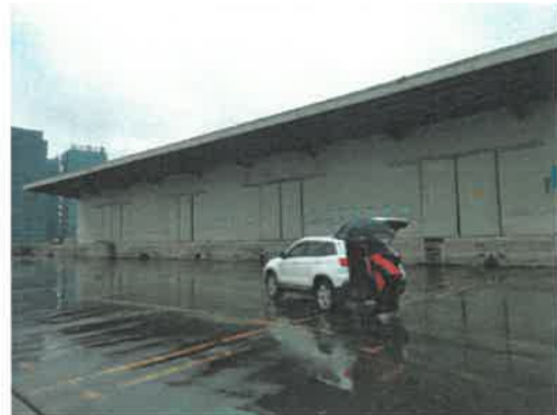
未经登记建筑(经认定为有证房屋) - 规划拆装箱库
