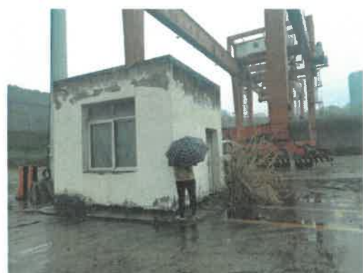
未经登记建筑-一期2平台码头管理间
