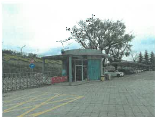
未经登记建筑-大门门卫室
