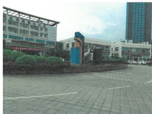
构附着物-综合楼喷泉及雕塑
