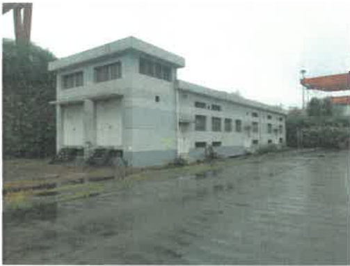
被征收的有证房屋-1号变电所
