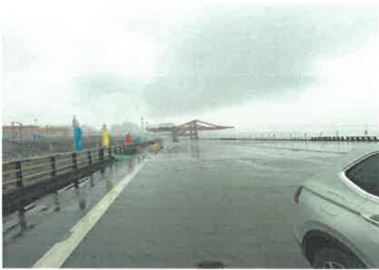
构附着物-码头及附属设施
