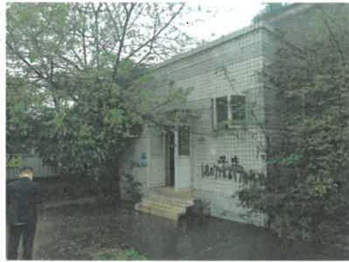
被征收的有证房屋-厕所
