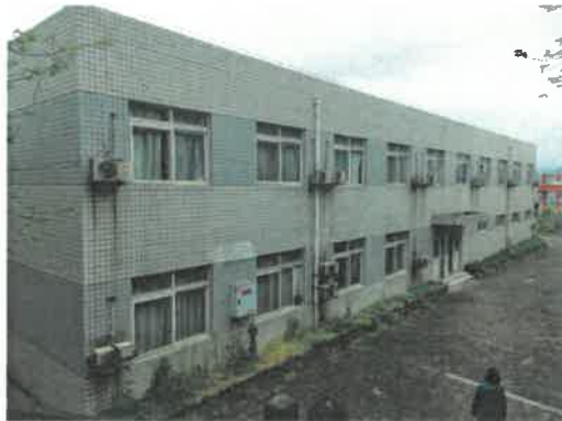
被征收的有证房屋-候工楼
