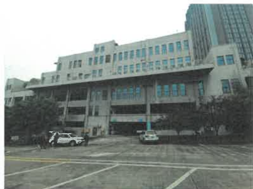
未经登记建筑(经认定为有证房屋) - 规划食堂
