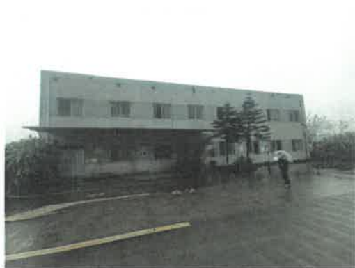
被征收的有证房屋-1号前方调度楼
