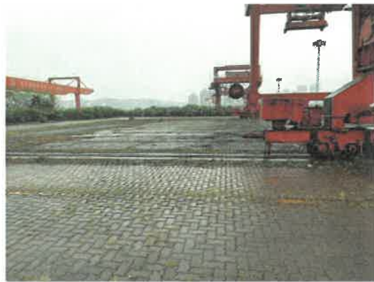
构附着物-码头及附属设施
