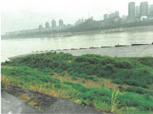
构附着物-码头及附属设施
