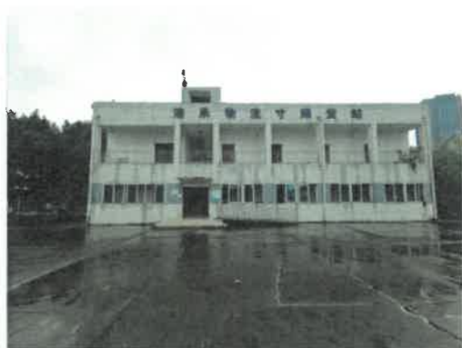
未经登记建筑-CFS 办公楼
