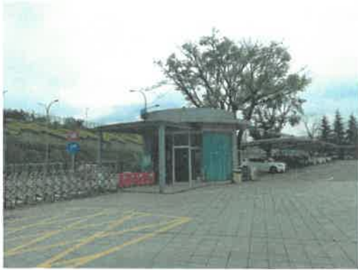
未经登记建筑-大门门卫室
