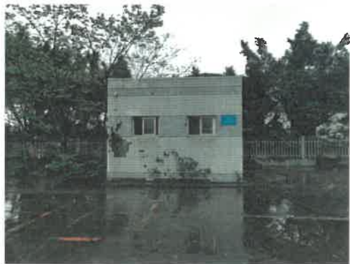
未经登记建筑-CFS 办公楼旁公厕
