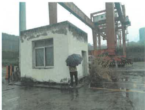
未经登记建筑-一期2平台码头管理间
