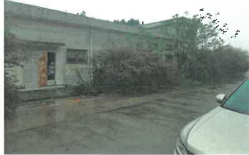
未经登记建筑(经认定为有证房屋) - 规划1#变电房
