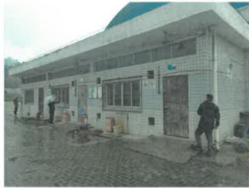
未经登记建筑-熏蒸药品库
