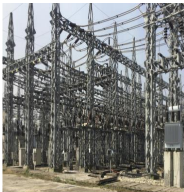
图 7：孟加拉 400/230KV GIS 变电站项目
