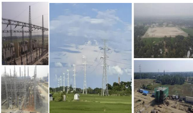
图 8：孟加拉国家电网升级改造项目
