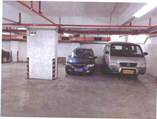
荔湾区大同路 103 号地下室
