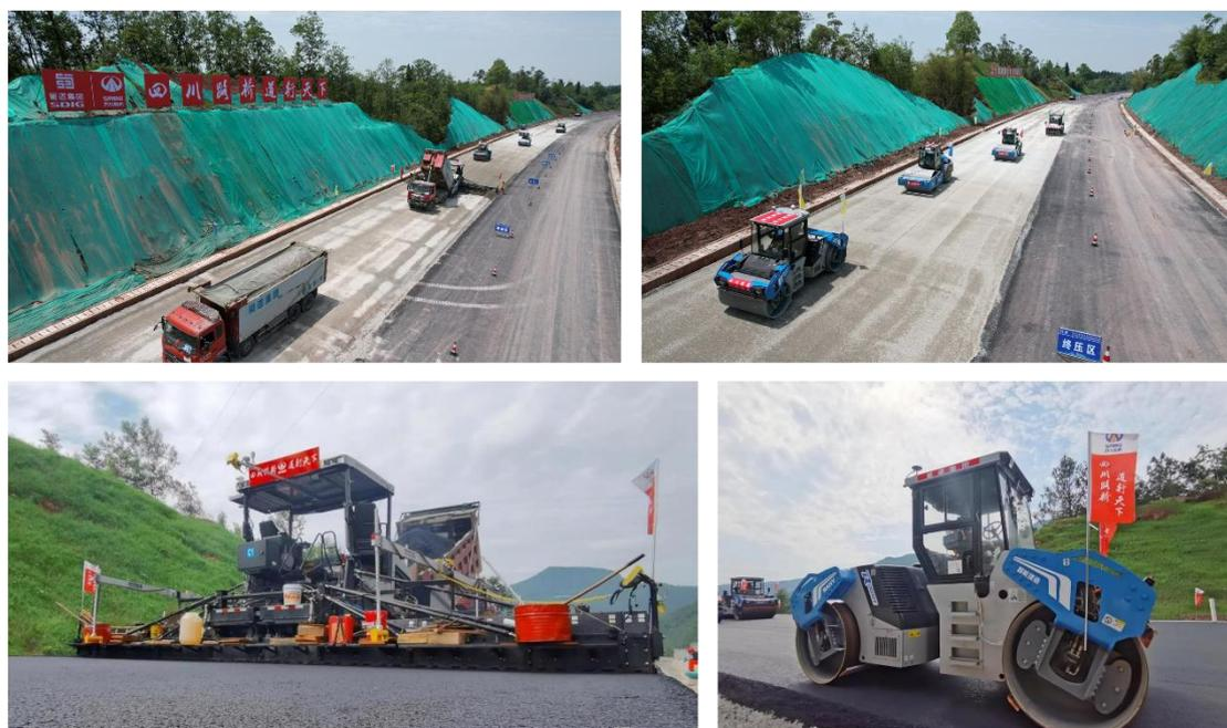
同时，智能摊铺机通过厘米级精准定位控制技术，实现精准的贴边摊铺压实作业，路缘及边角位置无需二次夯实，保证压实路面压实质量的一次成型；通过高精度定位和红外线温传感器等对摊铺过程中摊铺速度、厚度、温度及位置进行监测，进而实现对智能摊铺机的实时控制保证摊铺质量。智能压路机通过压实度传感器进行数据分析，避免欠压过压等问题；通过前后共两组组合雷达避障、利用高精度定位及车辆动态模型智能防撞、在施工场景中设置电子围栏等措施保障施工安全。
