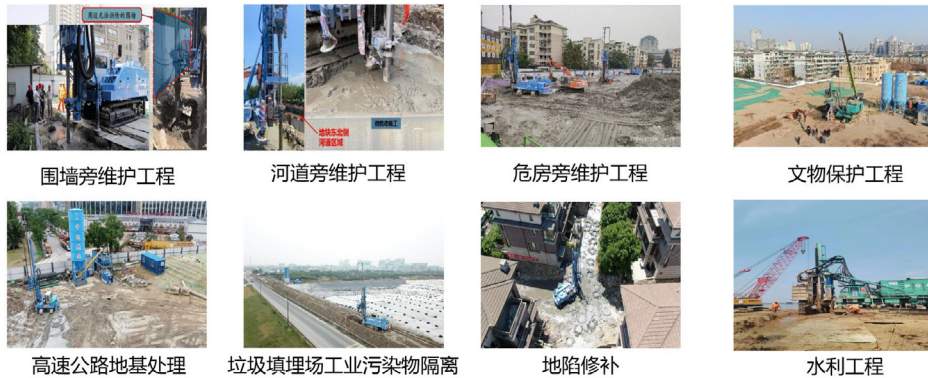
图注：不同场景的地下维修维护工程
