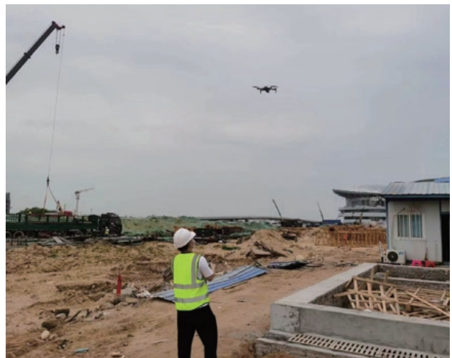
无人机巡查施工现场
