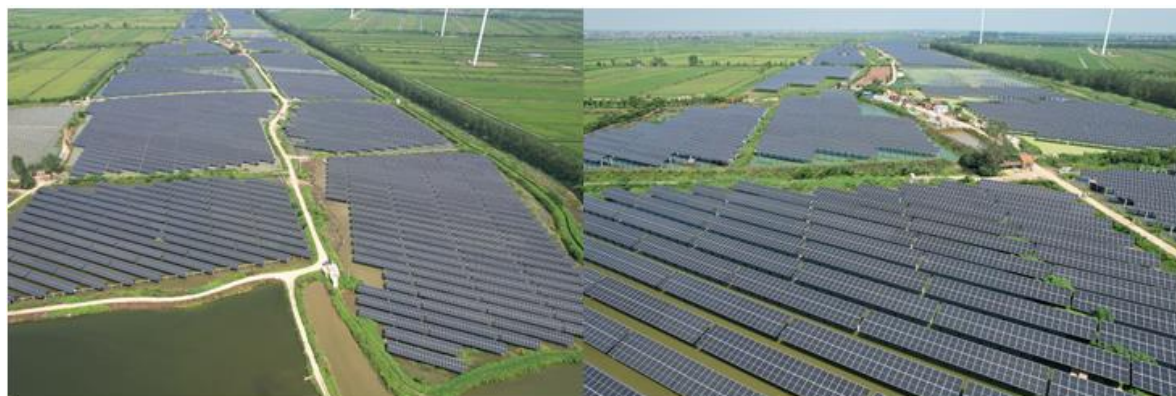
图 3：黄冈小池滨江新区 300MW 渔光互补发电项目（一期）
