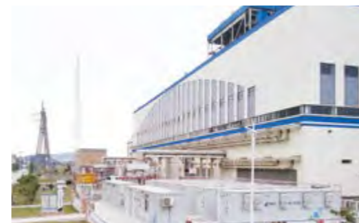
粤港澳大湾区首个世界银行贷款电池储能项目
