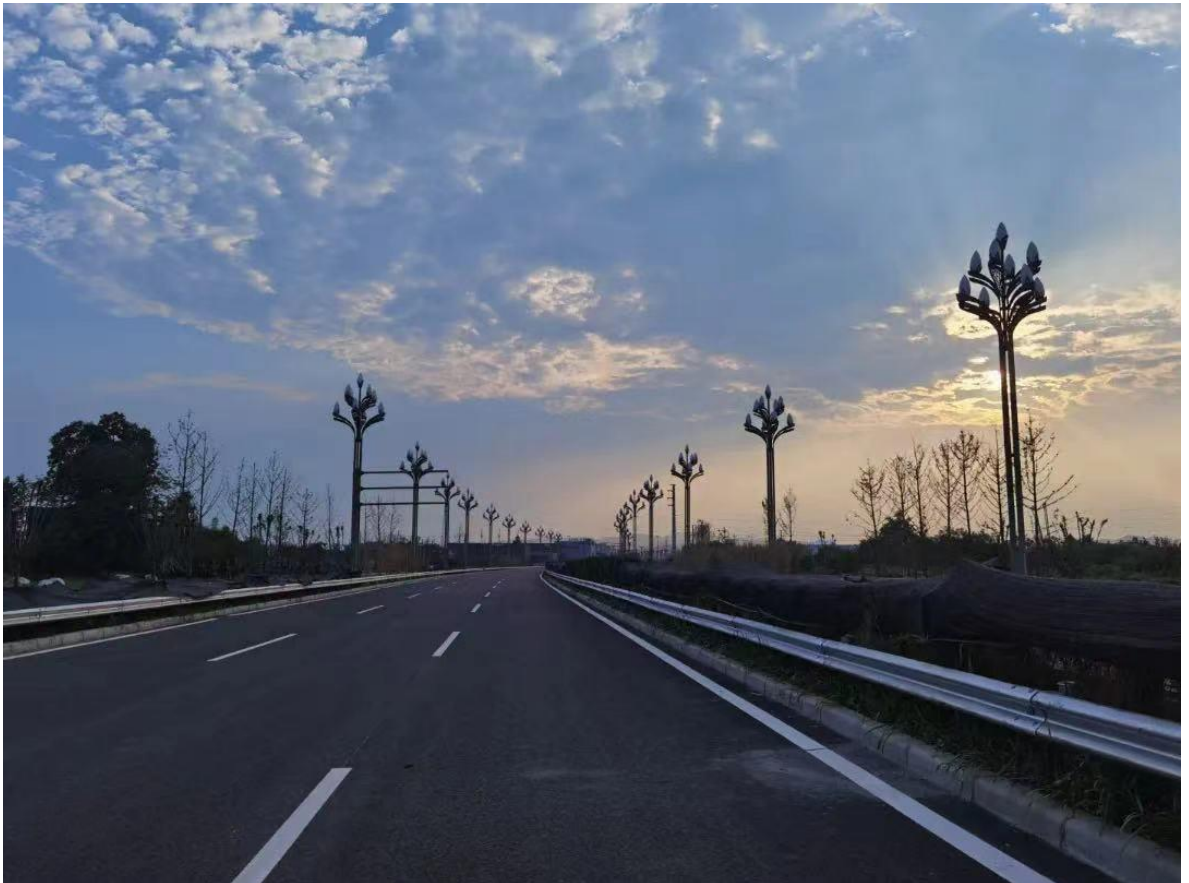
环天府新区快速通道项目
