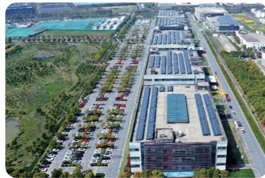
园区分布式光伏发电系统
