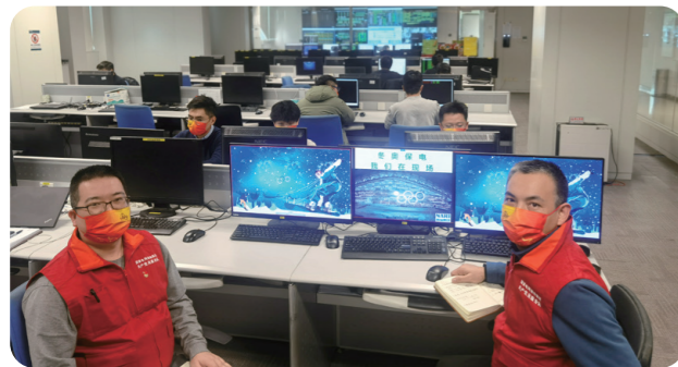
调度系统运维保障
