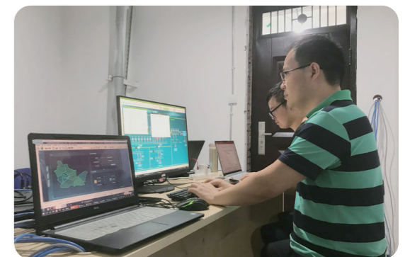
保障配电自动化主站系统运行
