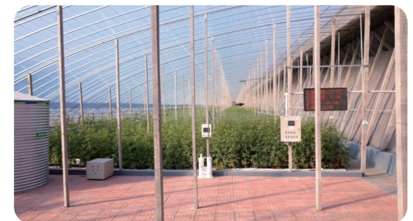
山东寿光智慧电气化大棚
