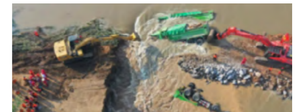
○ 水电九局六公司鹤壁分公司参与堤口抢险，成功封堵卫河决口
