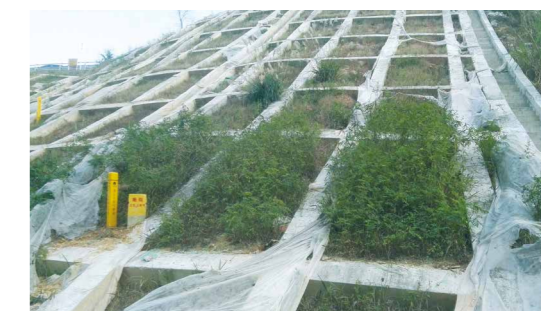
采取适当工艺减少边坡施工环节的水土流失
