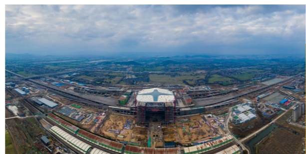
金属公司配送机场快线杭州西站项目
