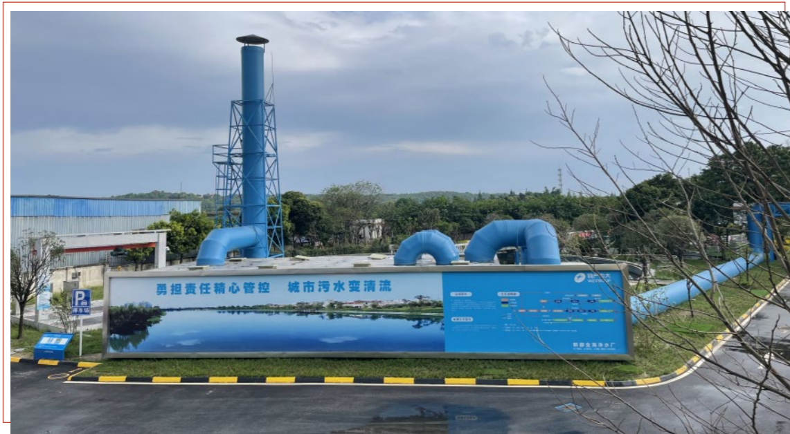
环境公司旗下成都金海净水厂
