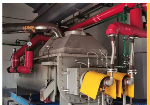
宏元药业新增污泥干化项目，减少固废排放
