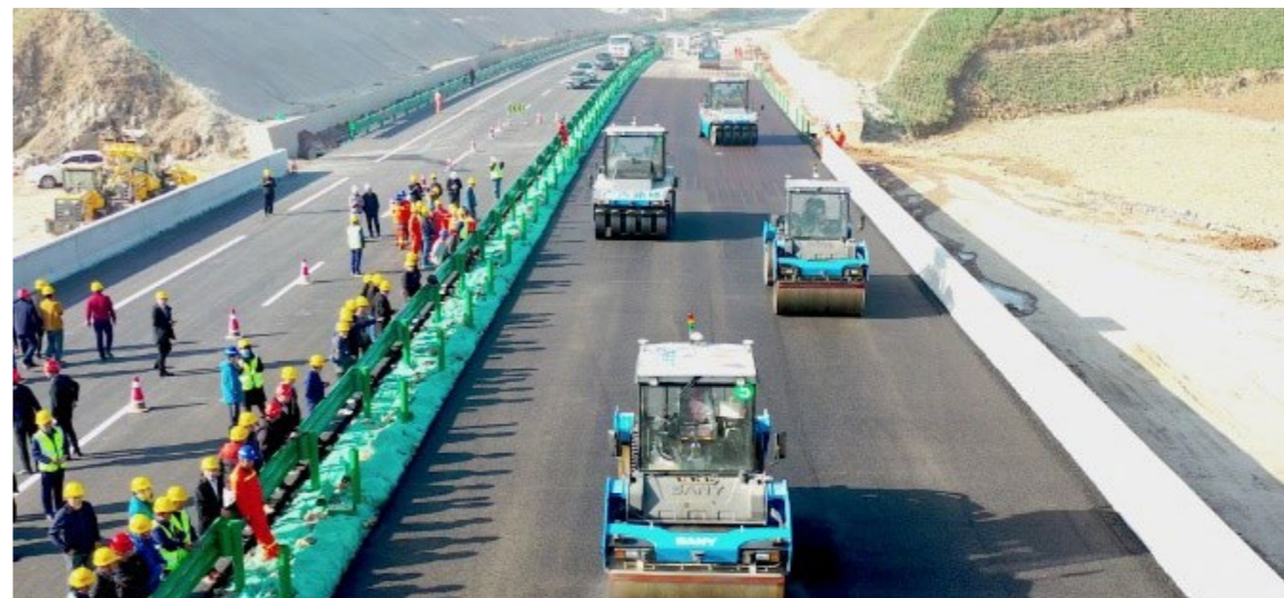
无人集群施工现场
