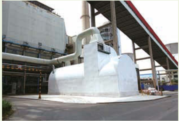
运河电厂燃煤耦合污泥发电项目
