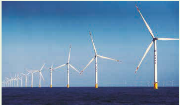
■ 华能山东半岛南4号海上风电项目
