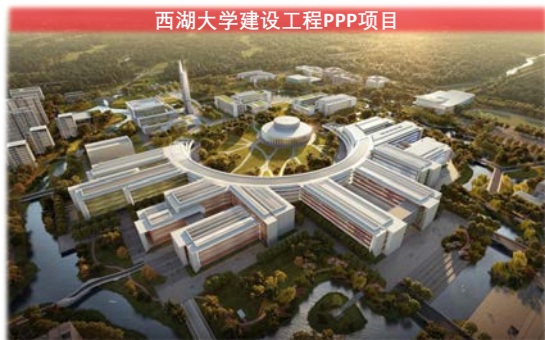
西湖大学建设工程PPP项目
