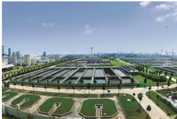
上海白龙港污水处理厂
