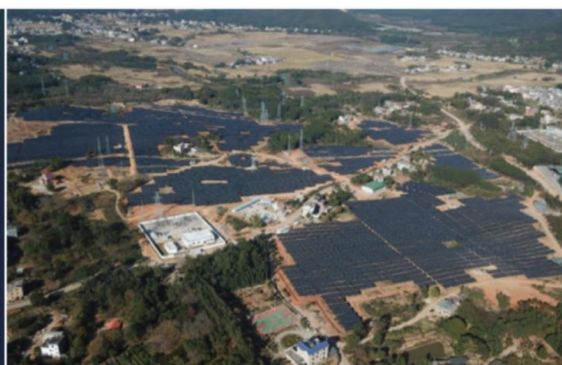
广东东源100MW光伏电站项目并网
