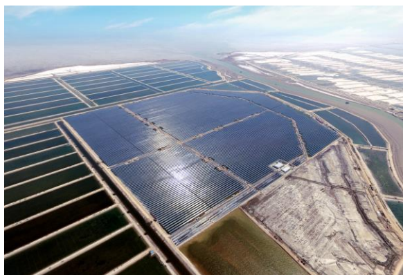
山东曙光光伏项目
