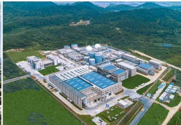
南京江北废弃物综合处置中心
