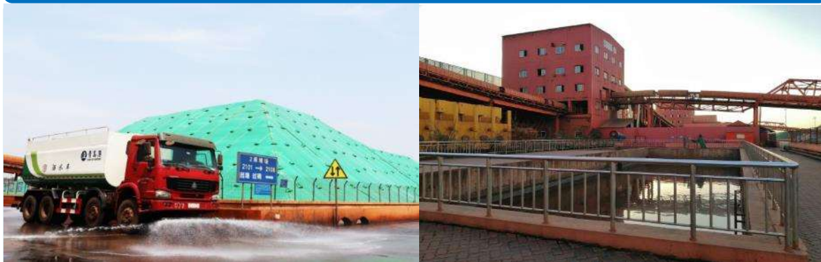
雨水、含尘污水收集处置和重复利用设施
