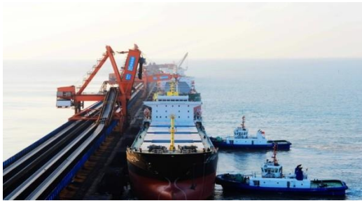
图：秦皇岛港区煤五期码头
