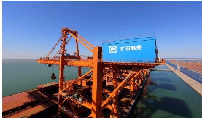
图：黄骅港区矿石码头正在进行装卸作业
