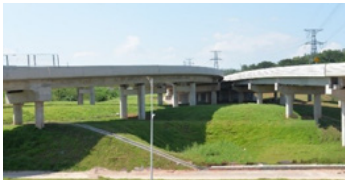
外环二期项目互通微地形改造
