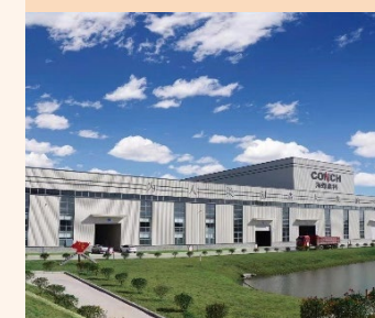
全椒海螺裝配式建築
