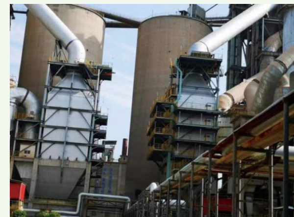
池州海螺SCR脫硝技改現場
