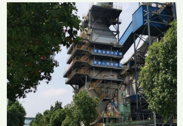
池州海螺SCR脫硝技改現場
