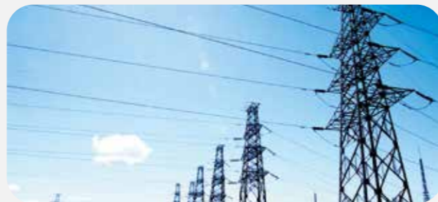
金寨光谷送出线路工程
