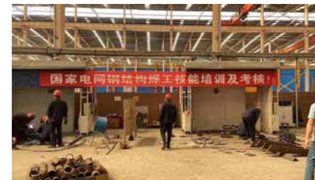
国家电网钢结构焊工技能培训及考核
