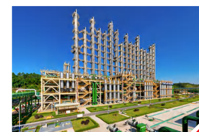
永祥股份高纯晶硅精馏塔装置
