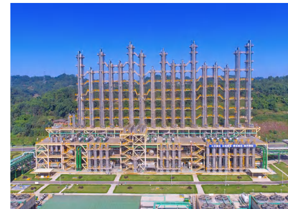
永祥股份高纯晶硅精馏塔装置
