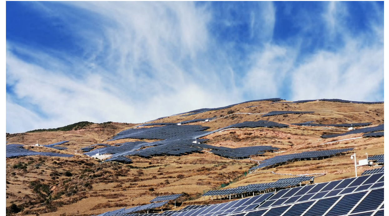
通威喜德县农光牧光一体光伏扶贫电站
