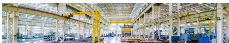
装配车间安装现场
