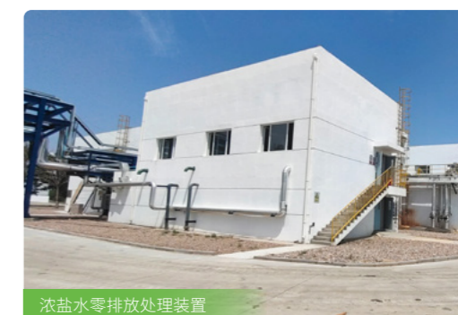
浓盐水零排放处理装置
