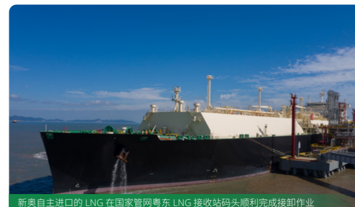
新奥自主进口的 LNG 在国家管网粤东 LNG 接收站码头顺利完成接卸作业
