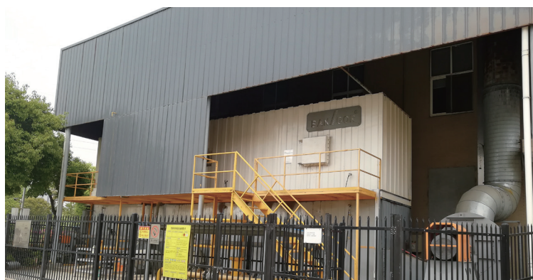
废气处理设施
