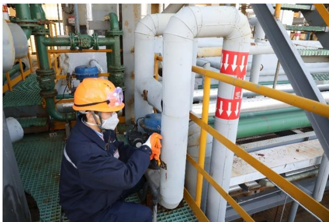
图注：扬农员工对次氯酸钠生产装置进行检修
