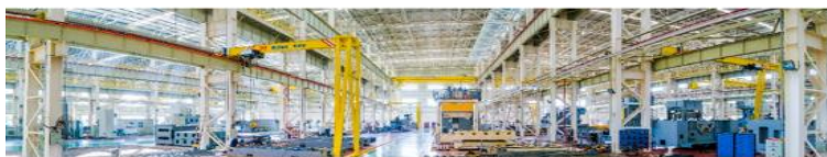
装配车间安装现场
