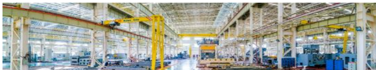
装配车间安装现场
