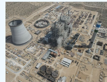
巴基斯坦塔尔 2 x 660 兆瓦燃煤电站项目
