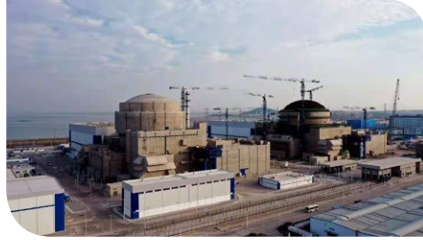
中国核建承建的华龙一号全球首堆并网成功
