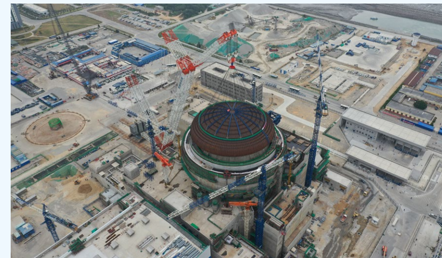
华龙一号福清核电 6 号机组外穹顶吊装
