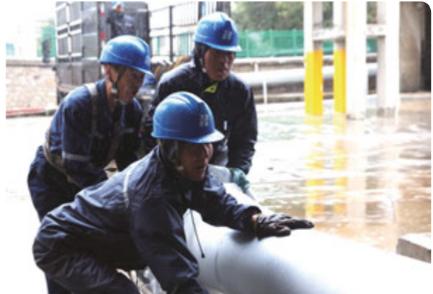
台风来临前设备抢修
