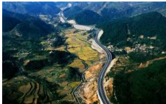
贵阳至新寨（黔桂界）高速公路
