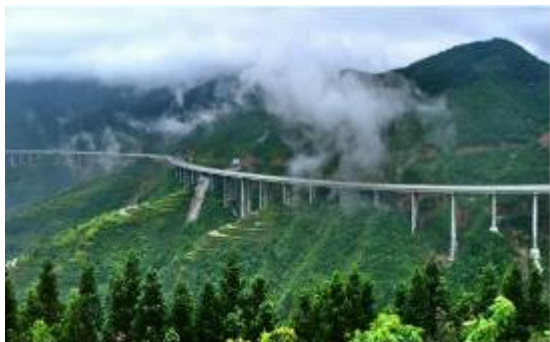
厦蓉国家高速公路贵州境水口至都匀段
