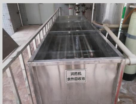
中药基地使用蒸汽余热回收利用装置
