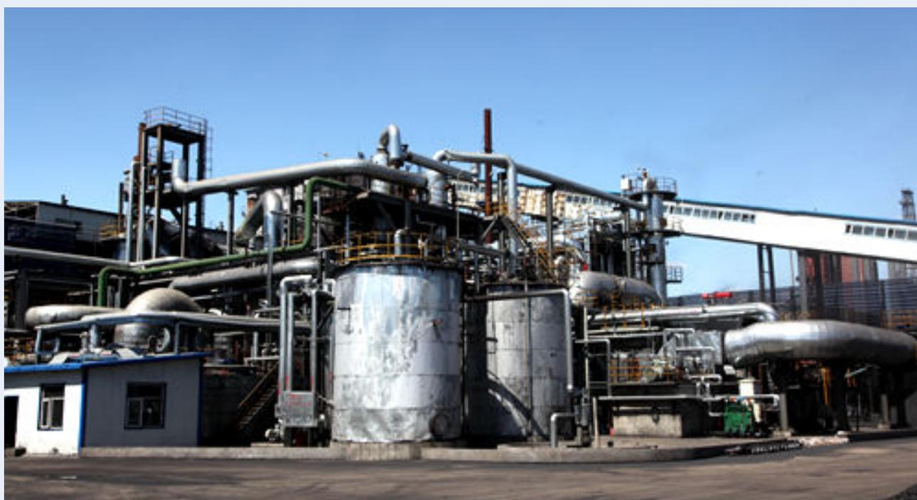
粉煤回转热解制取无烟煤中试装置
