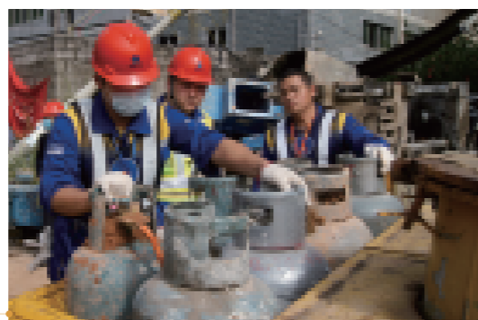
集中妥善处置挖掘出的钢瓶
