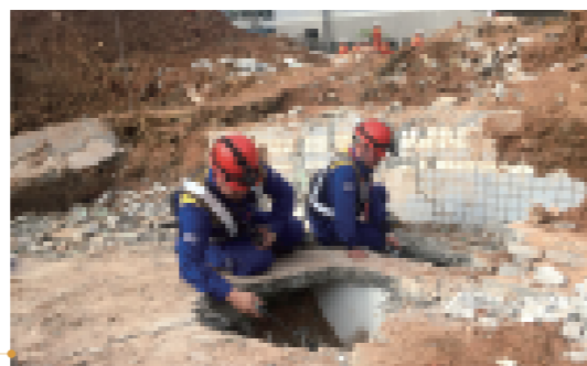
对燃气浓度进行检测
