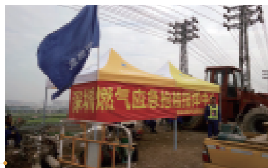
深圳燃气应急抢险指挥中心
