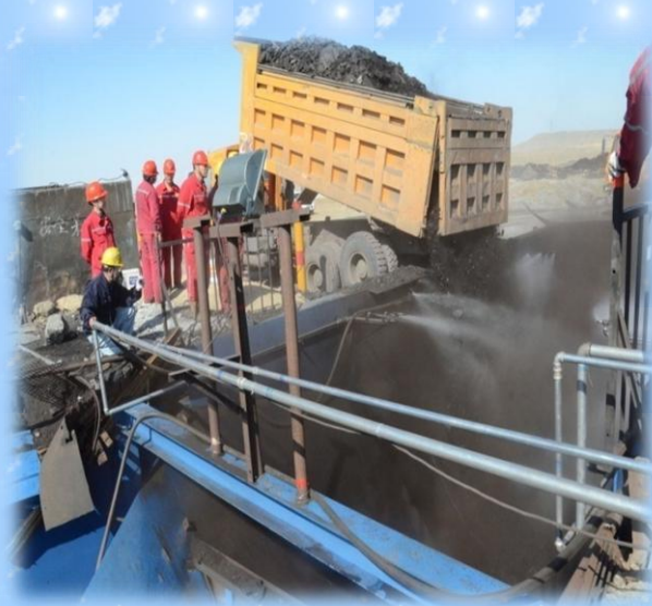
安装喷雾降尘系统装置后
