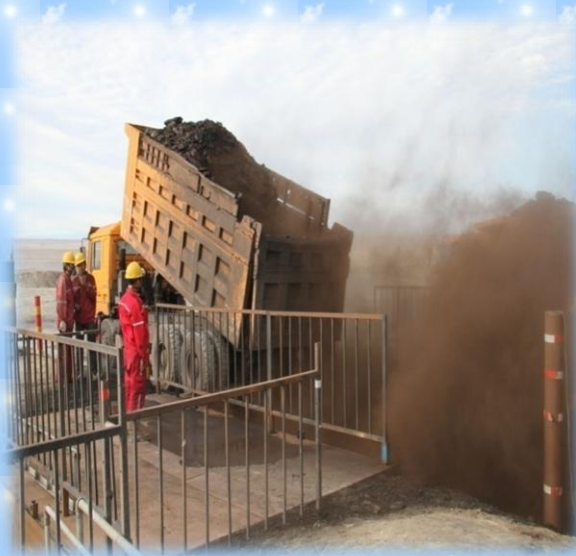
未安装喷雾降尘系统装置之前
