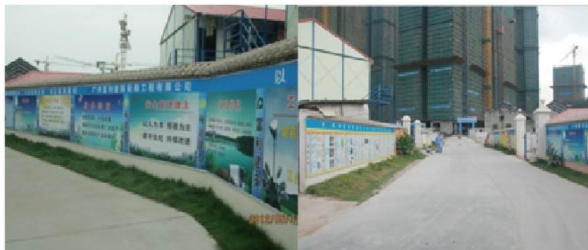
封闭式围墙临时道路硬化处理
